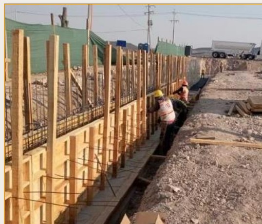
Muro y barda perimetral. El Salto
