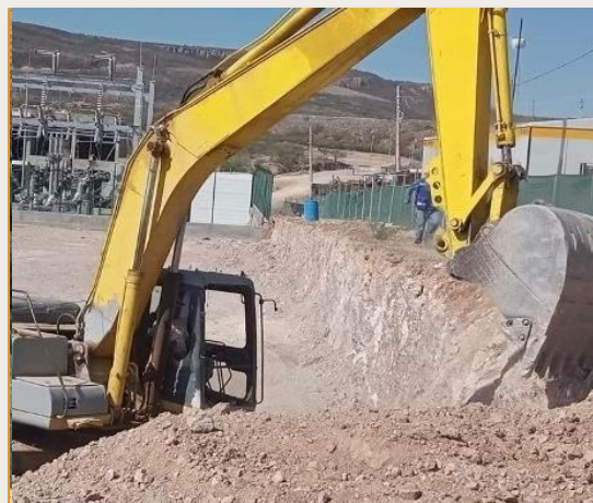
Terracerías. Muro y barda perimetral. Presa El Salto
